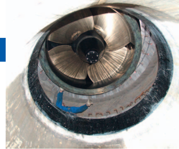
Der entscheidende Augenblick: Einbau der Turbine am neuen Krafthaus.
